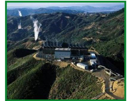
**Sistemi a vapore dominante:** normalmente coesistono nel serbatoio acqua liquida e vapore, che è la fase continua che controlla la pressione. Sono sistemi ad alta temperatura e normalmente producono **vapore secco** o **surriscaldato**. I sistemi geotermici di questo tipo sono molto rari (Larderello in Italia, The Geysers in California, Matsukawa in Giappone, Kamojang e Darajat in Indonesia).
